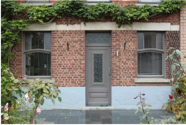
Afb. 4. Detail van het schrijnwerk, de vensters zijn nog origineel, de deur is vervangen.
