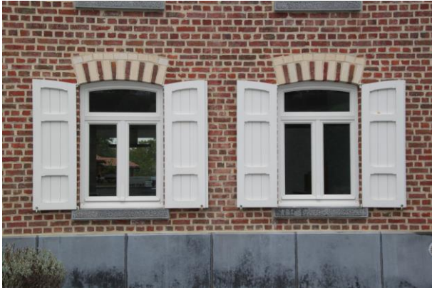
Afb. 4. Detail van het schrijnwerk vernieuwd naar voorgaand model.
