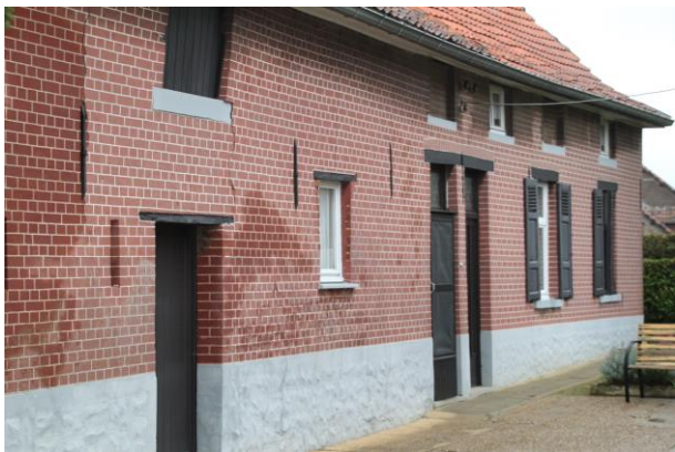
Afb. 5. De zuidelijke langsgevel van het boerenhuis en de stal is gecementeerd en beschilderd met een baksteenimitatie op een imitatie-breukstenen plint.
