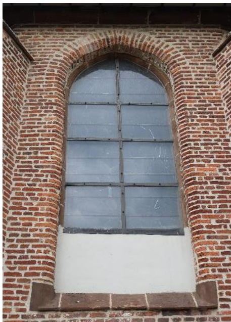
Afb.16. De ijzerzandstenen vensteromlijsting is nog zichtbaar achter de bakstenen buitenschil.
