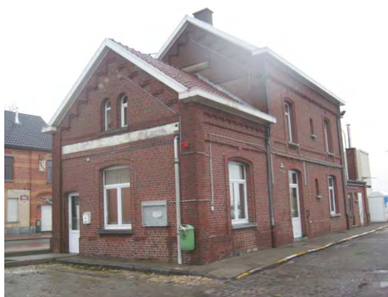
Foto 7: zicht op dienstgebouw
