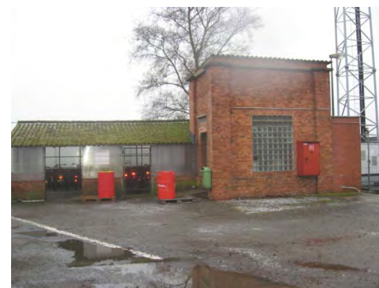
Foto 8: zicht op overdekte fietsenstalling, technische ruimte en zendmast
