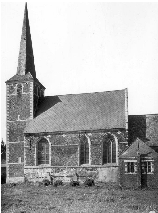
Afb. 25. De toestand van het kerkje ten tijde van de nieuwbouwplannen van pastoor Sloots. Let ook op het met gras begroeide en pas geruimde kerkhof. De aftekening van het zadeldakje op de zijgevel van de kerk duidt vermoedelijk op de voormalige aanwezigheid van een calvarie op het kerkhof. Foto van 1944 – Bron: KIK.
