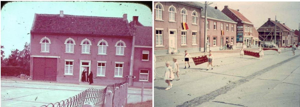
Afb. 7 en 8. De zusterschool in het derde kwart van de 20 ste eeuw met gecementeerde voorgevel – Bron: https://meensel-kiezege.be .
