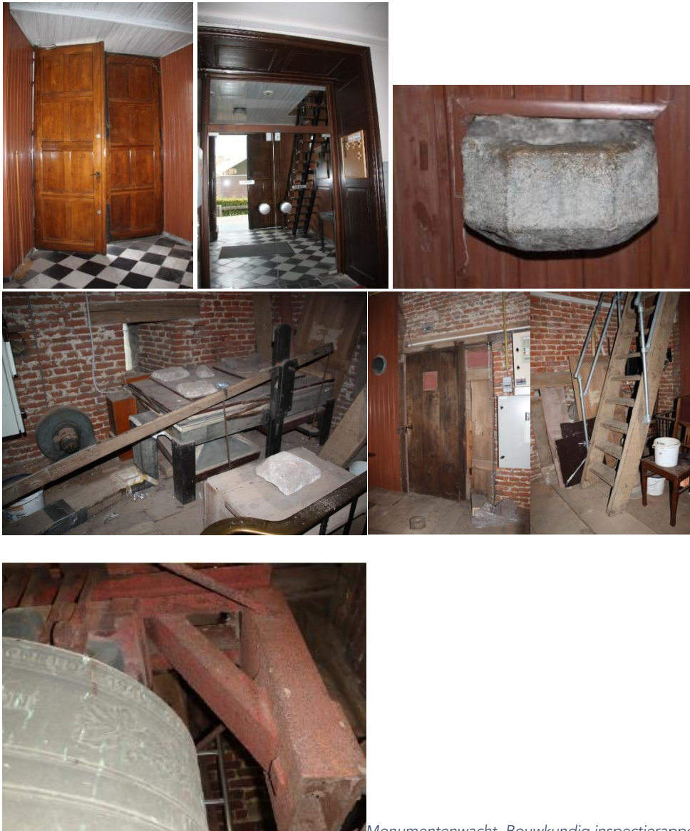
Monumentenwacht, Bouwkundig inspectierapport, 22343/2017/B, p. 17.
