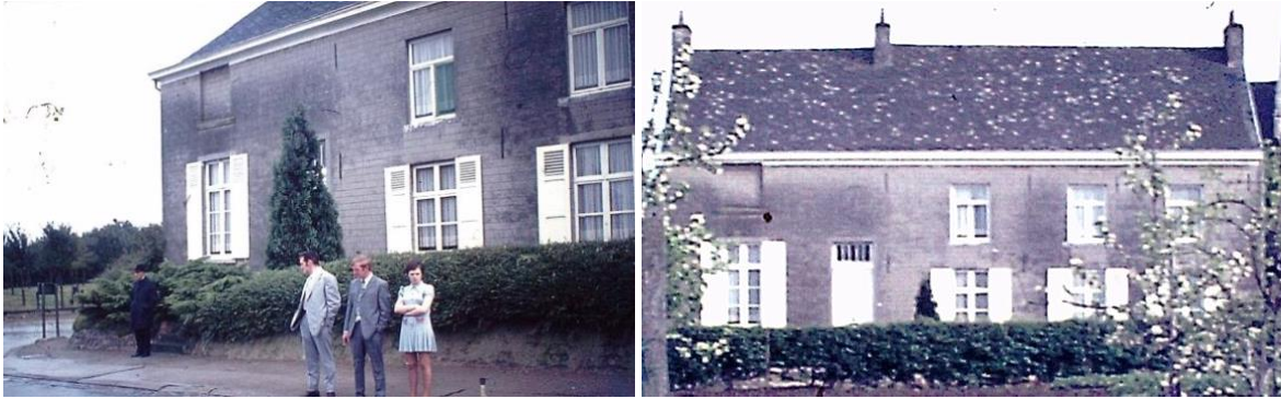
Afb. 6 en 7. De pastorie met gecementeerde voorgevel in de jaren 1960. De drie rechtste traveeën vormen het oudste gedeelte van de pastorie opgetrokken in 1820, de twee linkse traveeën werden omstreeks 1863 bijgebouwd - Bron: https://meensel-kiezegem.be/wp-content/uploads/2016/03/mk_pastorie.pdf .
