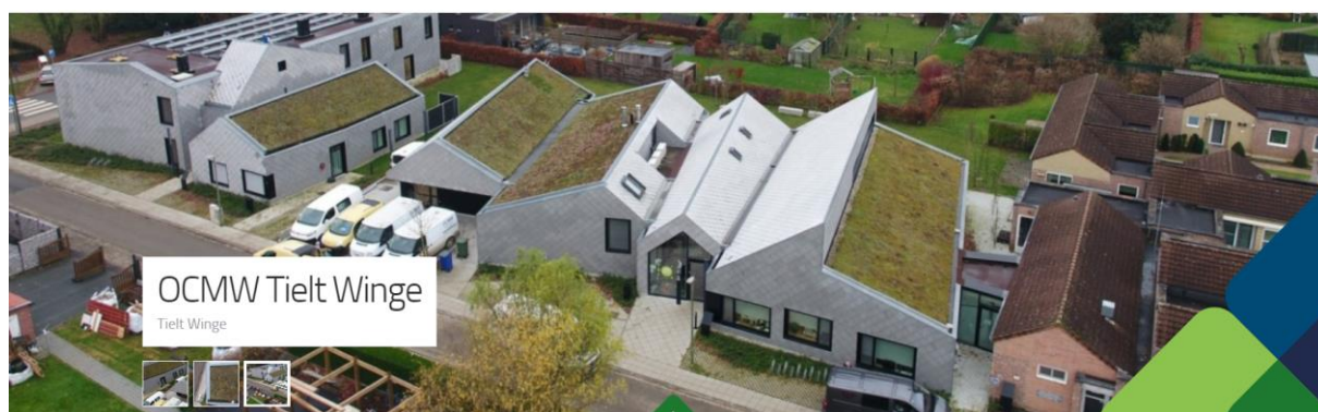
Figuur 34: Groendaken en regenwater hergebruikvoorzieningen in Tielt-Winge [18]
