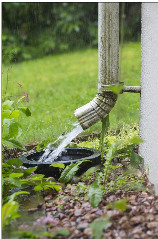
Figuur 120: Afkoppelen dakafvoer van het afvoerstelsel.
